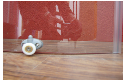
Dveřní díl osadit těsněním o pojezdy Put the magnetic stripe and rollers onto the door part.
