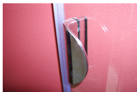
Instalovat madlo install the grab handle
