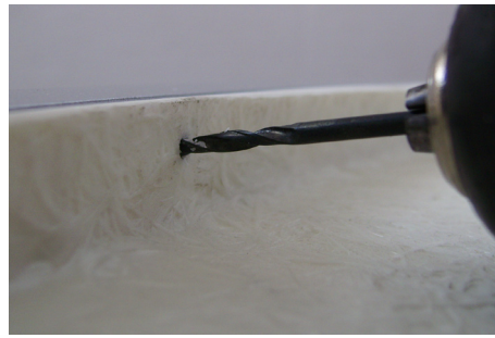
Vrtat vrtákem 3,2 mm Use 3,2 mm drillw
