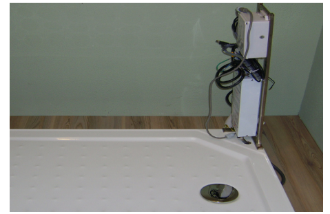
Instalovat generátor install the generator
